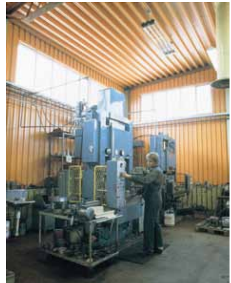
Зачем обогревать весь объем цеха если там всего несколько рабочих мест? Их локальный обогрев с помощью инфракрасных обогревателей позволит значительно снизить затраты на отопление.
