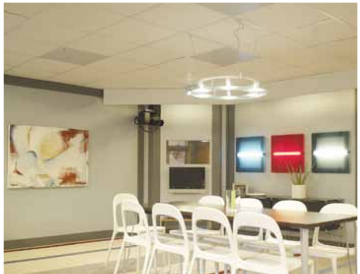
Потолочные кассеты обогревают помещение оставаясь практически незаметны. При необходимости их расположение легко изменяется
