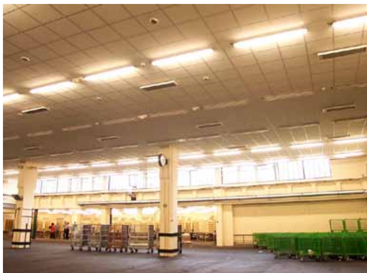
Инфракрасное излучение от приборов поглощается элементами помещения, мебелью и телом человека. Это обеспечивает комфортность обогрева даже для помещений большого объема.
