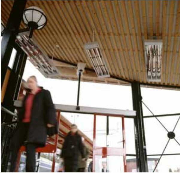
На станциях железных дорог и метро приборы IR часто используются для нагрева поверхности пола во избежание образования наледи.
