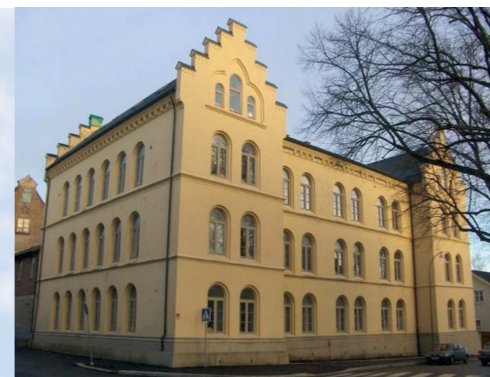
Реконструкция школы в Фредрикстаде, Норвегия имела требования к низкому энергопотреблению, а также к возможности транспортировки вентиляционного оборудования через небольшие монтажные проемы. DVCompact выполнил их.
